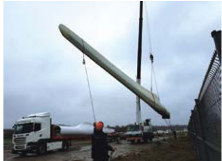
Installation de la pale EFFIWIND en composite acrylique 100 % recyclable sur le site de CANOE Lacq
